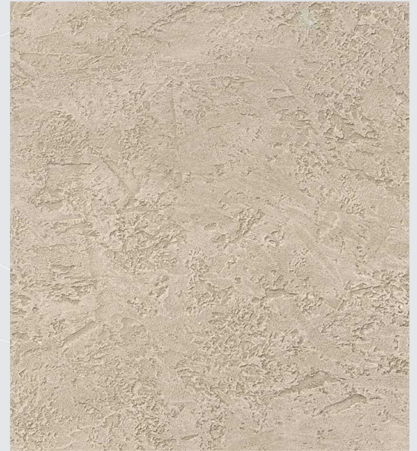
Nachbildung Putz / Beton mit Pietrafine weiß; anschließende Farbgebung mit Velatura PR7-100-VE und PR7-050-VE
